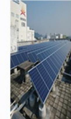
为响应国家新能源建设号召，加快国内光伏发电规模化应用。8月18日，新会生产基地太阳能光伏屋顶发电项目开工建设。本项目建设规模容量为779.79KWP。每块太阳能板最大输出功率255W，总共安装3058块太阳板，年发电量约为100万Kwh，每年可减少1290T标煤，每年可减少20.6吨so<sub>2</sub>排放量。
